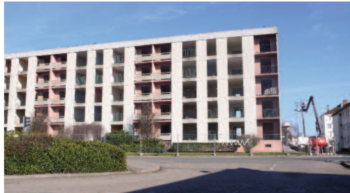
Destruction d'une barre d'immeubles. Mais pour quel avenir ?
